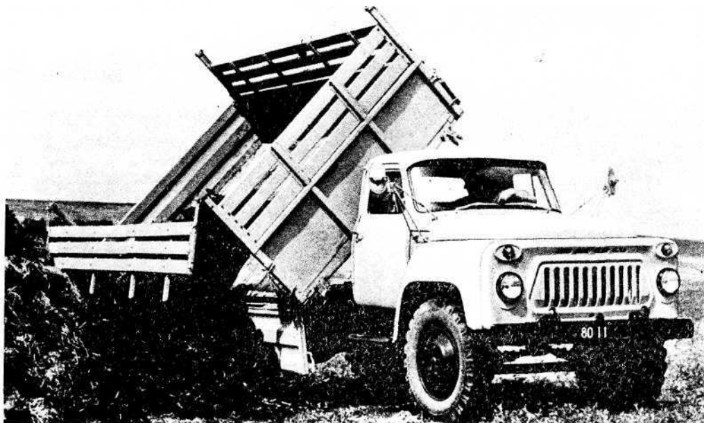
Самосвал САЗ-ГАЗ-53Б с трехсторонней разгрузкой. 1966 г.
